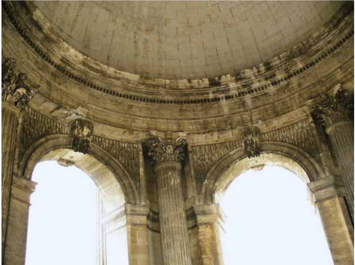
Intérieur du « Château d'eau » © Patrick Séguy
