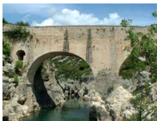
Pont du Diable à Saint-Guilhem-le-désert
